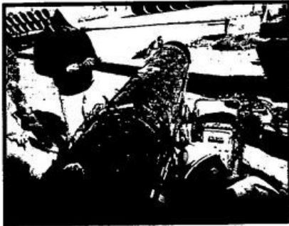
procedimiento de electro fusión con equipo PLASPI TEC KAL 8000
